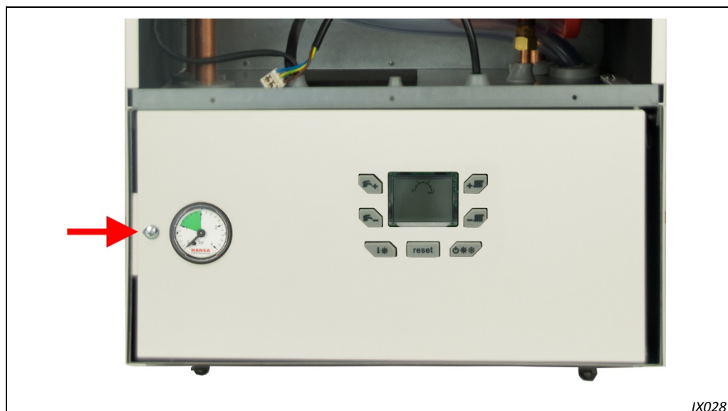
Рис. 18: Открытие передней крышки
